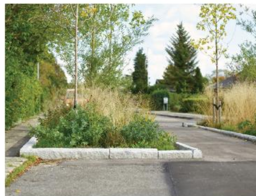
Eksempel på et regnbed med beplantning, der har en hastighedsdæmpende tillægsværdi
